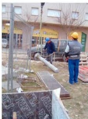
Foto 19: Dipòsit a peu d'obra de la columna
