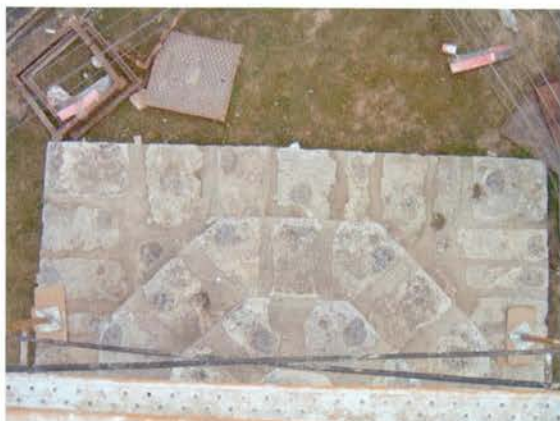
Foto 22: Vista de la base des de la part superior de la bastida. Es veu la numeració.
