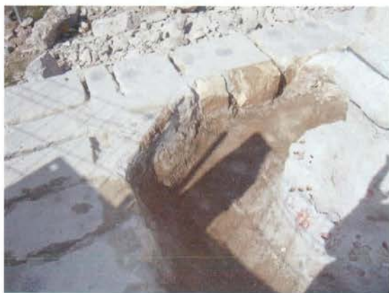
Foto 34: Detall des desmuntatge del nucli central del primer esgraó del basament..
