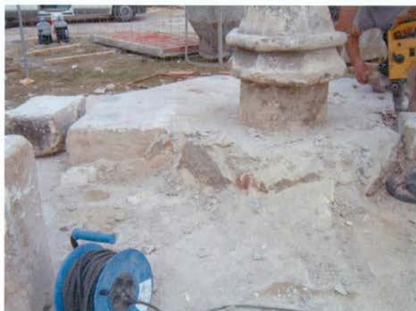
Foto 32: Detall procés de demuntatge .
