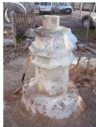
Foto 37: Detall de la base de la columna després de desmuntar el basament.
