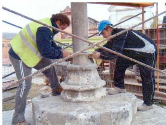
Foto 15: Vista procés de separació de la part baixa de la columna..
