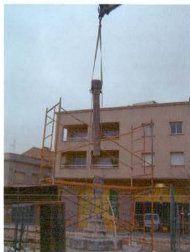
Foto 18: Extracció de la columna amb la ploma.
