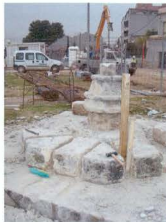
Foto 31: Detall del procés de desmuntatge del basament .
