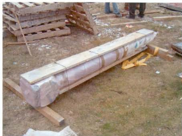
Foto 20: Detall de la protecció de la columna.
