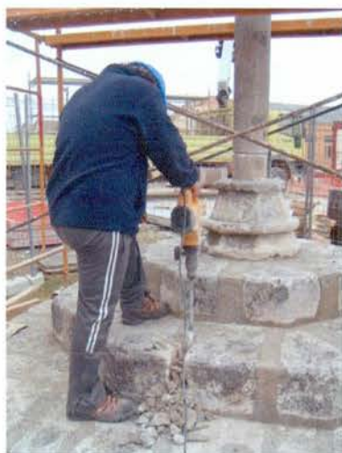
Foto 17: Detall de l'inici de l'extracció de les pedres del basament .
