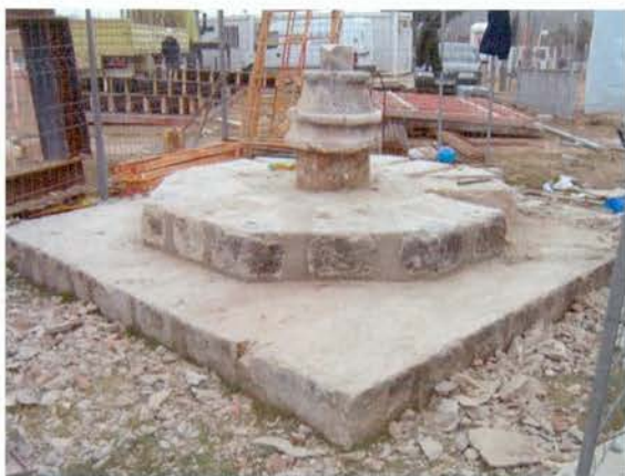
Foto 30: Detall del basament després de desmuntar el tercer esgraó..
