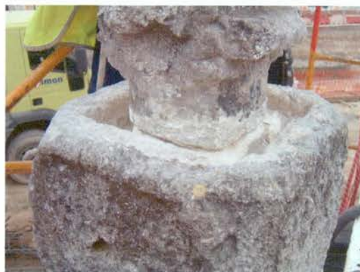
Foto 6: Detall encaix de la Creu de Coronament amb el nus.
