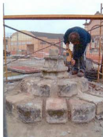
Foto 27: Procés de desmuntatge del basament
