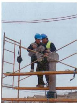
Foto 9: Detall procés extracció Creu de Coronament.
