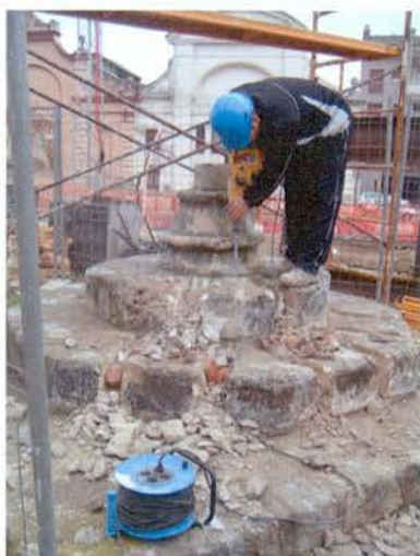
Foto 28: Desmuntatge del segon i tercer esgraons del basament
