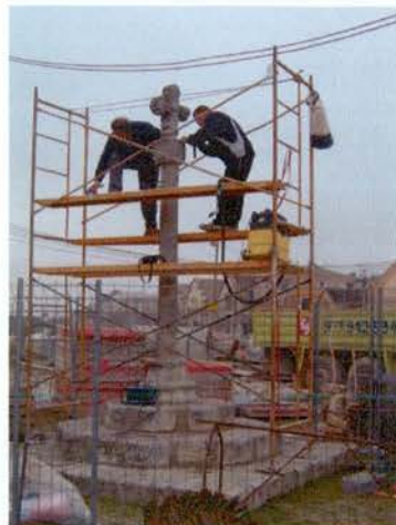
Foto 8: Procés d'extracció de la Creu de Coronament.
