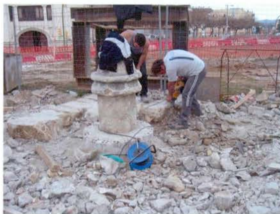
Foto 36: Vista del desmuntatge del primer esgraó del basament.
