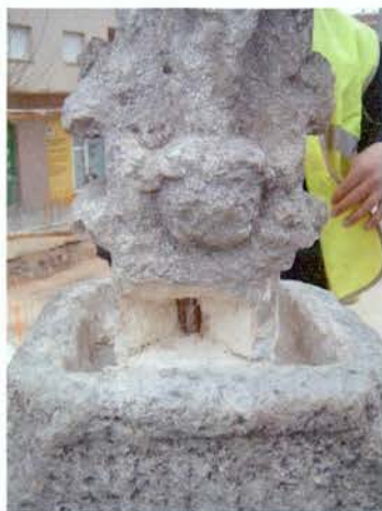
Foto 7: Procés d'extracció de la Creu de Coronament.
