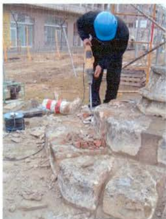
Foto 26: Inici del desmuntatge del basament
